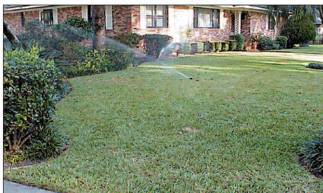
Figura 8. Diseño deficiente; el sistema no provee los niveles requeridos de agua. El área necesita ser re-zonificada, separando el césped de las otras plantas.
