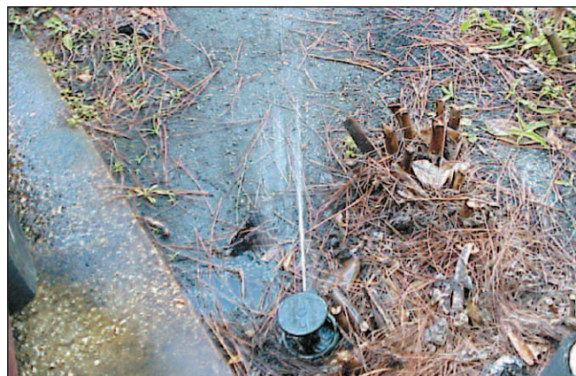
Figura 10. Objetos interfiriendo con el patrón de dispersión, lo que resulta en una uniformidad y una distribución pobre.
