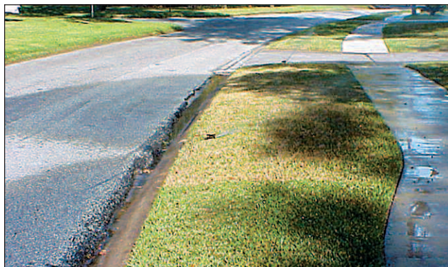
Figura 7. Diseño de baja calidad; los aspersores no cubren el área requerida.
